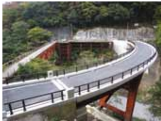
(対岸の道路：県道篠原宇井線) 橋種：方杖ラーメン箱桁橋 延長：57m 幅員：5m 総事業費：597,285千円 (平成27年11月現在)
