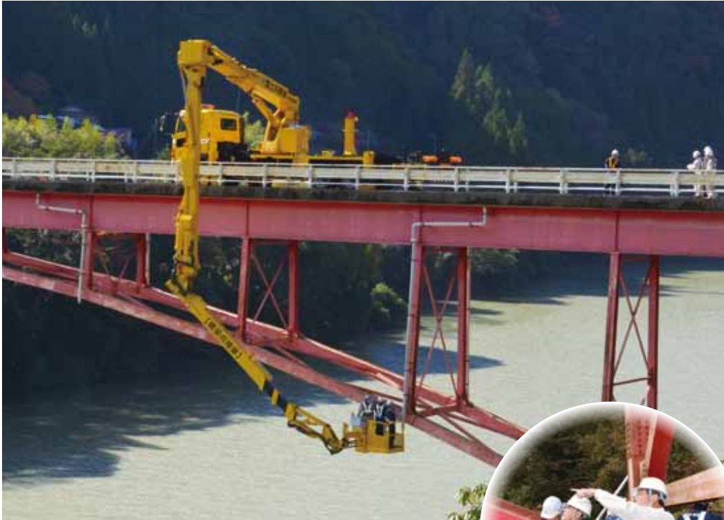
国土交通省橋りょう点検車両での点検風景
